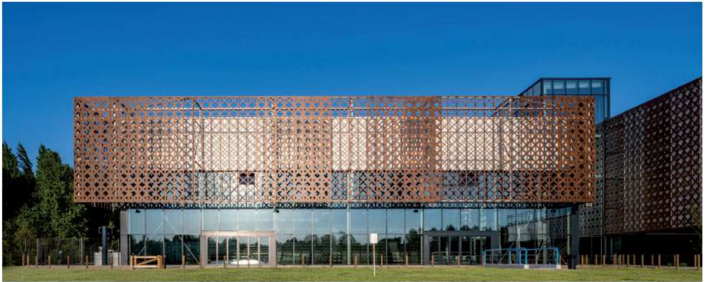
Tel un grand embarcadère, l'équipement se veut signal architectural parmi les espaces naturels du lac des Dagueys.
