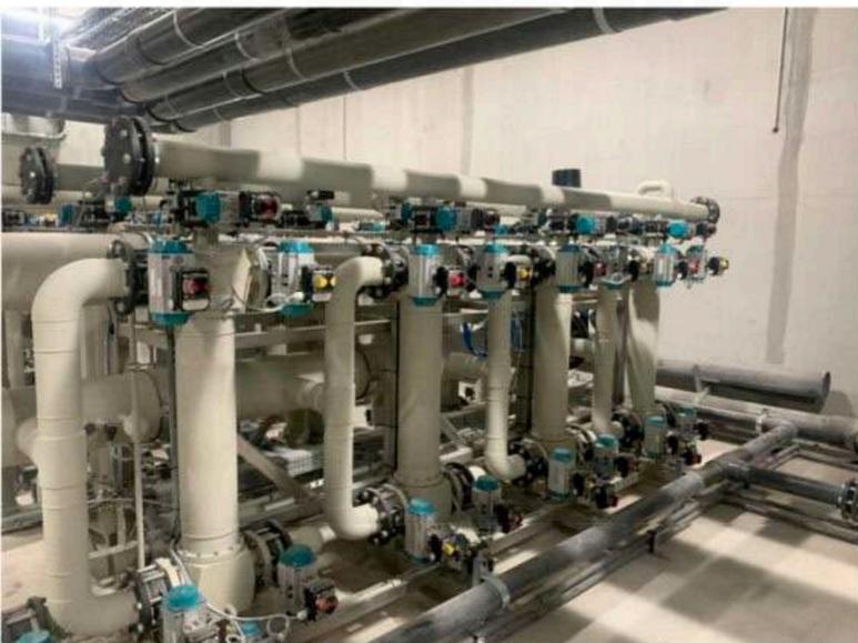
Les filtres en céramique permettent une économie de 60 000 m cubes d'eau par an. © K. R.
